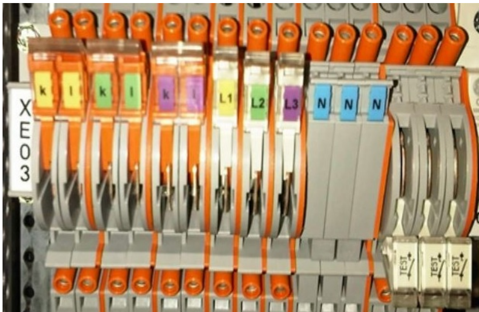
Abbildung – Wandlerklemmleiste (z. B. Beispiel WAGO Bestell-Nr.: 60297702 Art.-Nr.: 8001-001/K011-0034/000-100))
